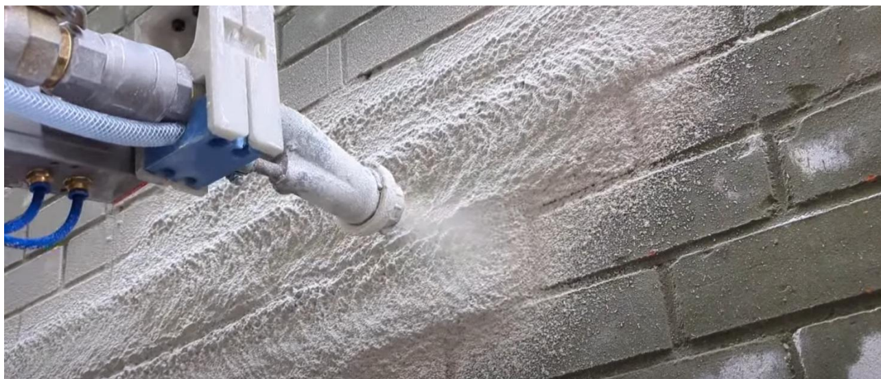
Projection robotisée d'enduit sur façade — bras 6 axes embarqué sur nacelle. © Builder Assist
